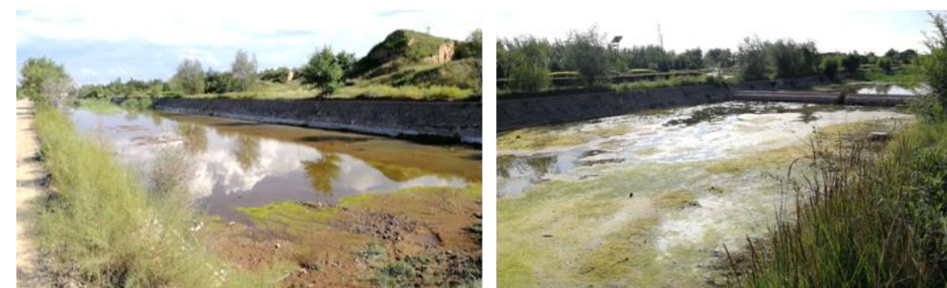
图6. 城北防洪渠-泥沙沉积与水体富营养化
