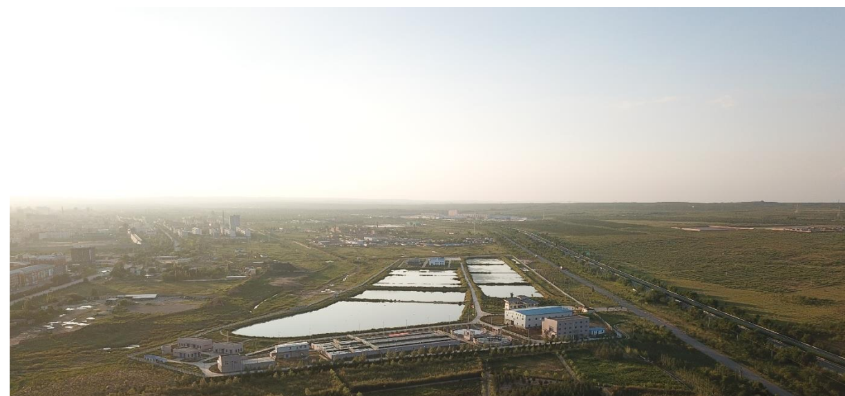
图14. 盐池县现状污水处理厂
