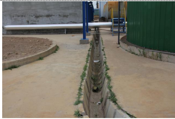
生产装置区 U 形混凝土排水沟 (2021.9.24)
