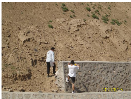
临时堆土场区挡渣墙措施验收照片
