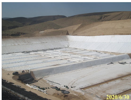
填埋场铺设防渗及渗滤液收集设施
