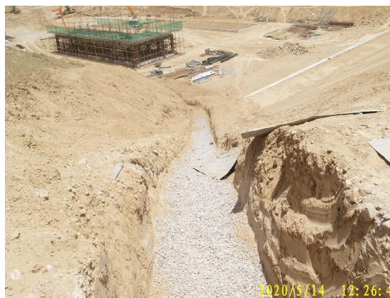
填埋场截洪沟施工
