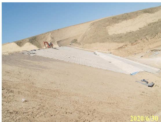
坝体外边坡浆砌石护坡施工
