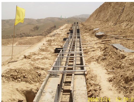
填埋场截洪沟施工
