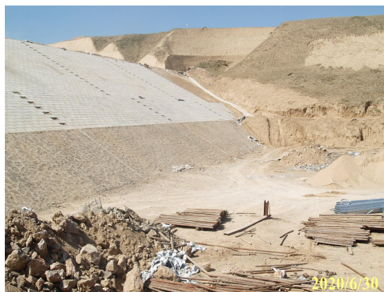
坝体外边坡浆砌石护坡施工
