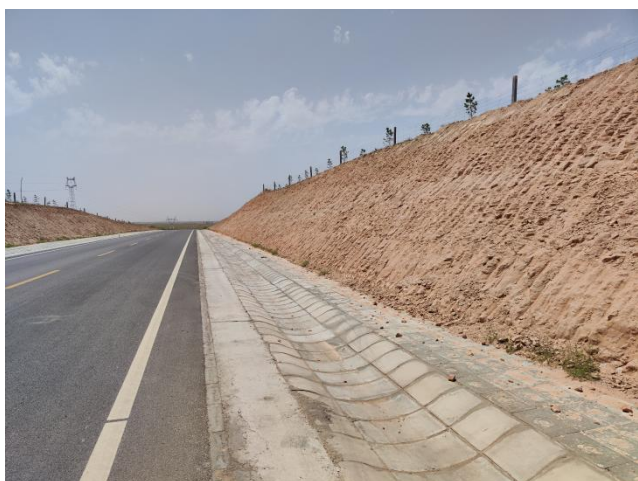
k26+690 浅碟形边沟及挖方边坡-2022. 08
