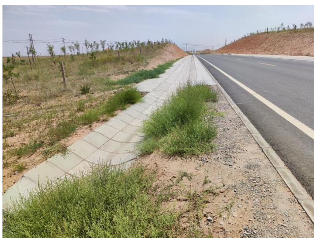
k25+892 浅碟形边沟及挖方边坡-2022. 08
