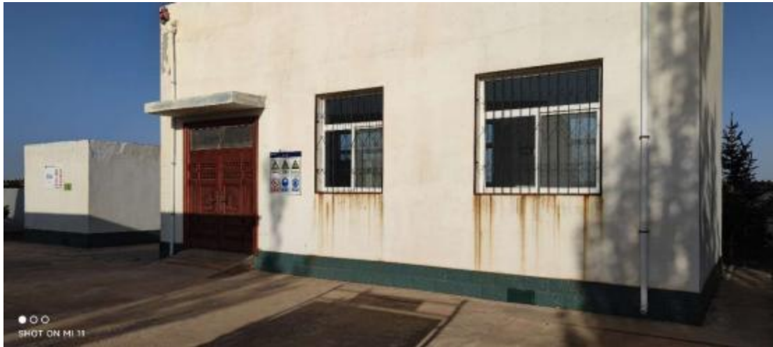
李记沟一泵站现状
