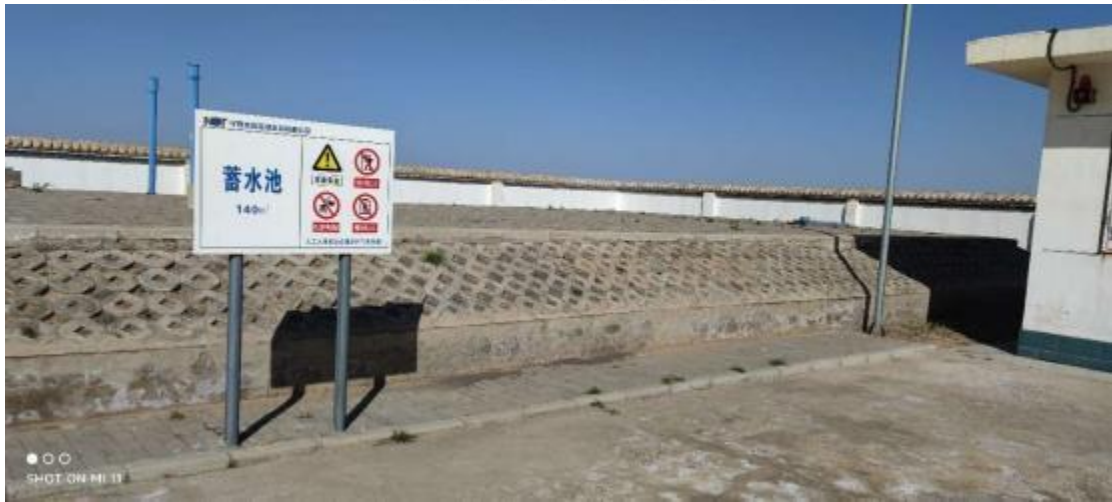
张记梁蓄水池现状
