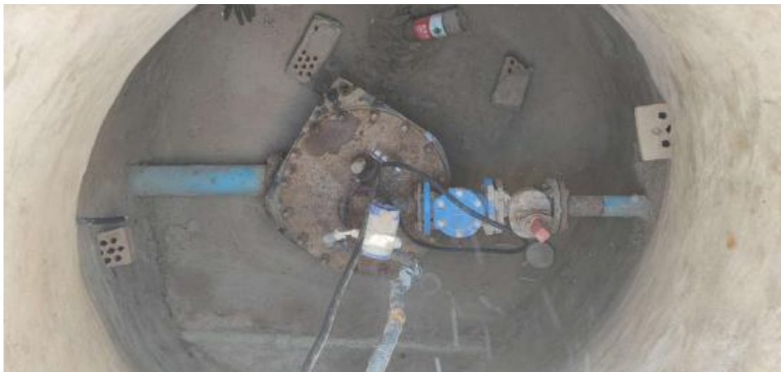
王下窝泵站潜水泵现状
