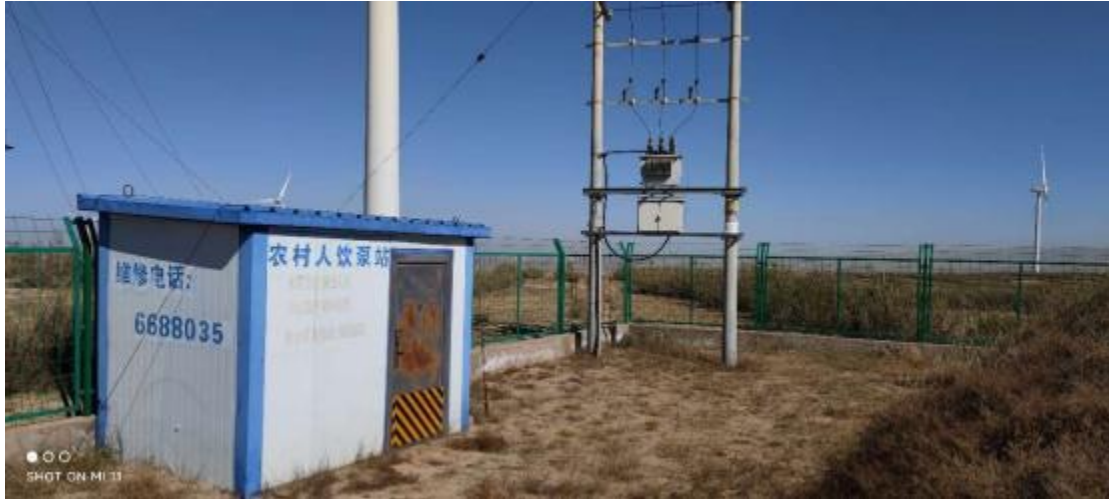
王下窝泵站变压器及彩钢房现状
