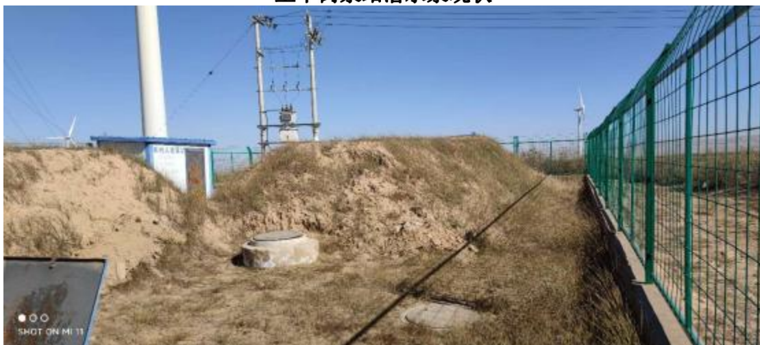
王下窝泵站场院及蓄水池现状
