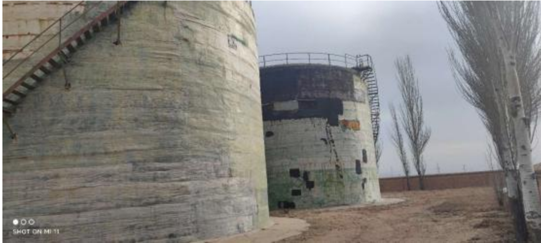
大水坑钢制圆柱形蓄水池现状
