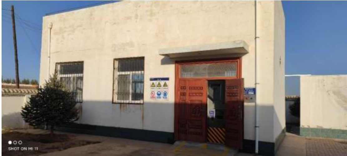
李记沟二泵站现状
