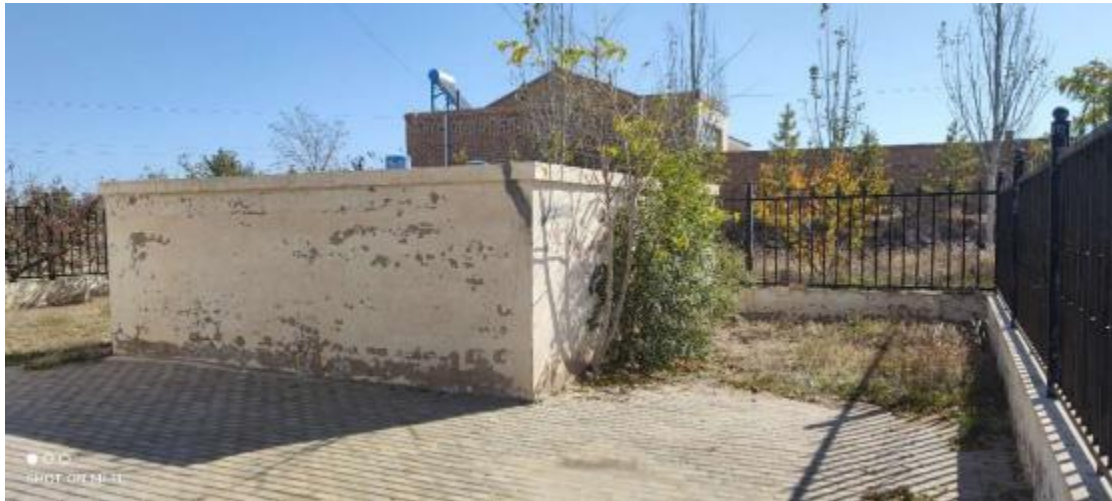
关记沟泵站蓄水池现状
