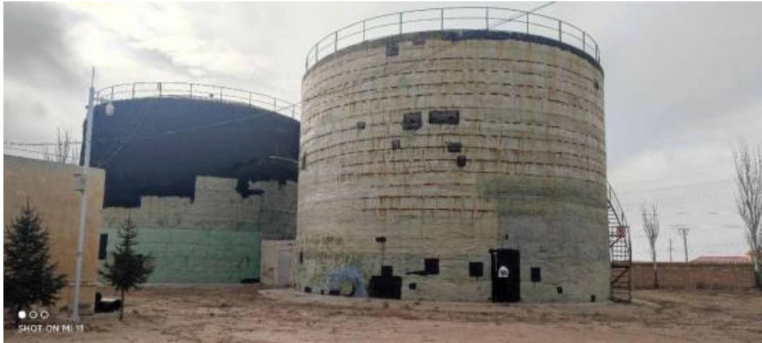
大水坑钢制圆柱形蓄水池现状
