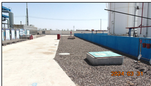
围墙内侧布设碎石覆盖措施，拍摄时间：2024.3月
