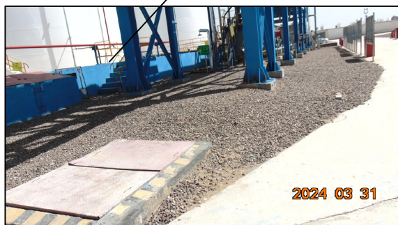
储罐围堰周边布设碎石覆盖措施，拍摄时间：2024.3月
