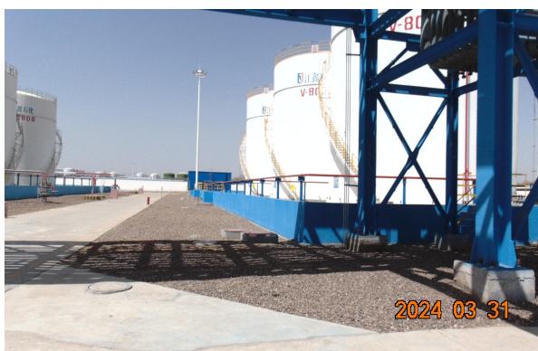
储罐围堰周边布设碎石覆盖措施
