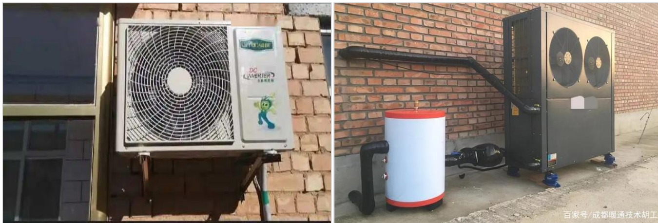
图 6-7 供热燃气设施
