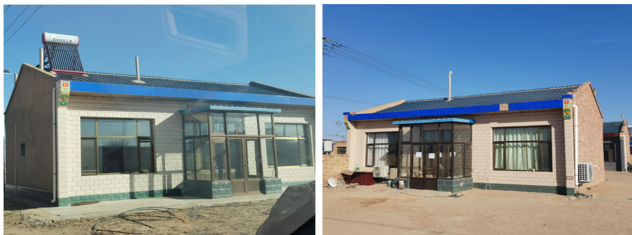
图 2-5-3 孙家楼村建筑质量 A 级
