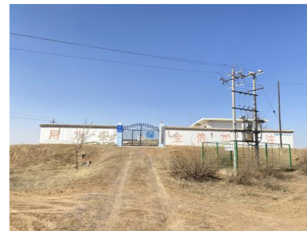
张记梁蓄水池
