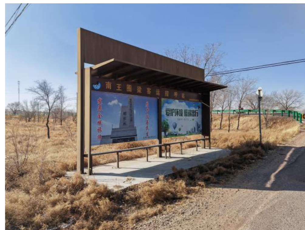
皖记沟村客运招呼站
