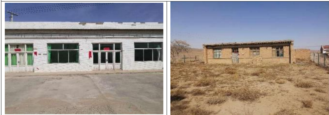
图 2.9.3 建筑质量一般房屋
