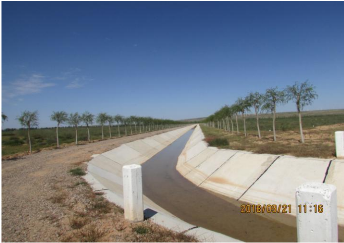
引水渠道砾石覆盖
