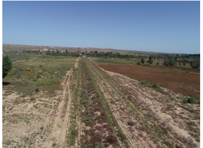
输水管道植被恢复
