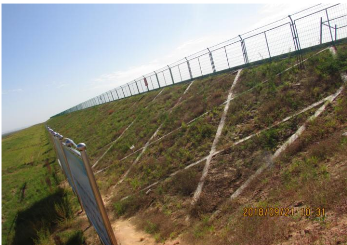
水库区混凝土隔条
