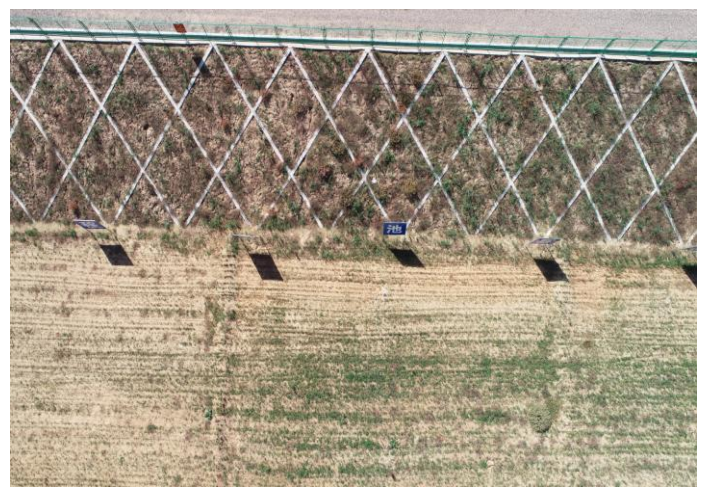
水库区混凝土隔条
