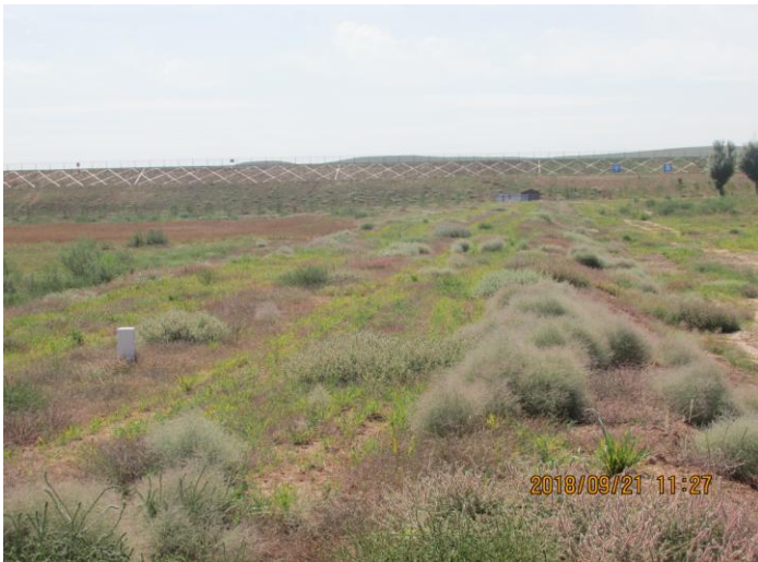
输水管道植被恢复
